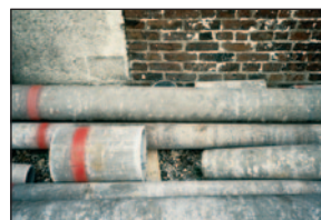
© INRS Canalisation en amiante ciment
