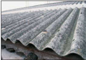
© INRS Toiture en amiante ciment
