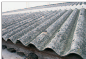
©INRS Toiture en amiante ciment
